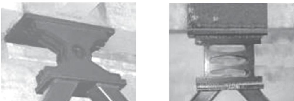
Рис. 3. Способы интегрирования стальных демпферов в структуру здания
