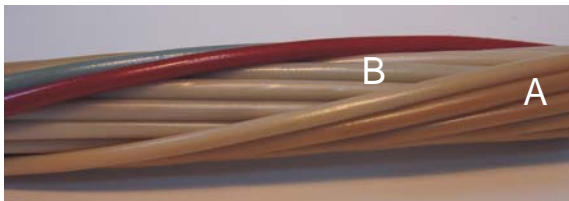
Рис. 1. Внешний вид отрезка кабеля КПВГ-27х2,5 после 20 лет эксплуатации
