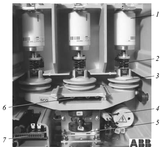
Рис. 6. Вакуумный контактор серии VSC 7 (7,2 кВ) производства АВВ
