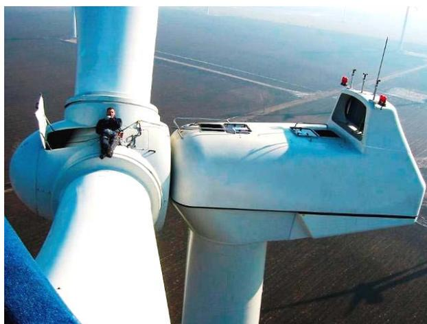
Рис. 5. Редкое фотоизображение момента техобслуживания на высоте около 70 м лопастей и ротора турбины современной горизонтально-осевой трехлопастной ВЭУ установленной мощностью до 1500 кВт сухопутного базирования [11]
