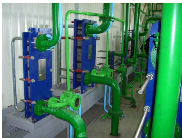
Рисунок 3 – Пластинчатые конденсатор и холодильник ректификационной колонны
