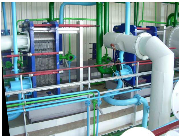
Рисунок 1 – Пластинчатые дефлегматоры производства фирмы «Альфа Лаваль» установленные компанией АО «Содружество-Т» в отделении ректификации
