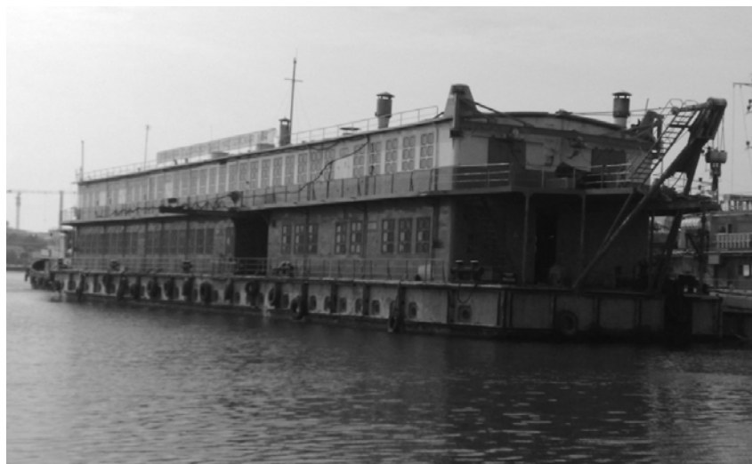
Рисунок 1 – Общий вид плавучей ремонтной мастерской (ПРМ) судоремонтного завода (г. Севастополь)
