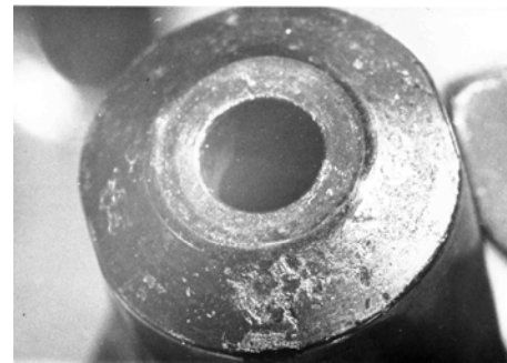
Рис. 2 – Пошкодження верхньої торцевої поверхні повзуна (якора)
