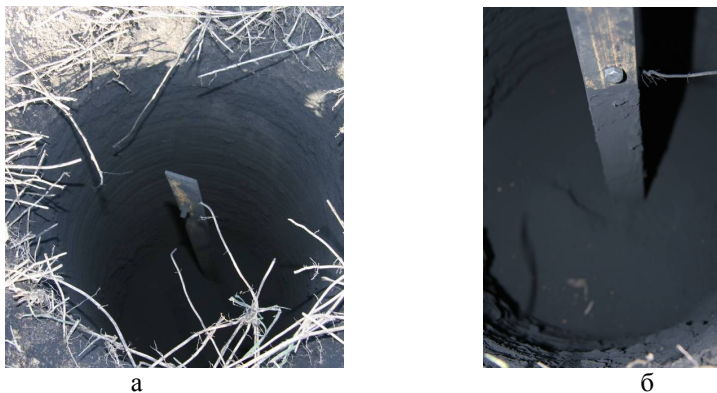
Рис. 2 – Вертикальные электроды повышенной проводимости растеканию: а – без покрытия; б – с покрытием.
