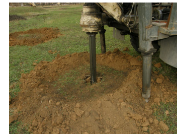
Рис. 1– Скважины под электроды повышенной проводимости растеканию
