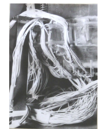
Рис. 21. Установка терморезисторов в зоне крепления подвески корпуса к опорному кольцу (вариант А)
