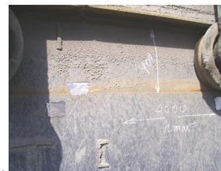
Рис. 7. Замеры толщины по балкам ходовым, зачищено место на участке механического сужения в связи с воздействием ролика и на свободном участке (ОШС черт. 126.00.00.000)
