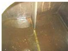
Рис. 5. Вода в полостях базы (ОШС черт. 126.00.00.000)
