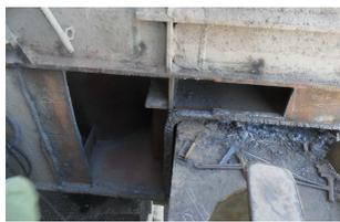
Рис. 9. Удаление поврежденных стенок и листов усиления
