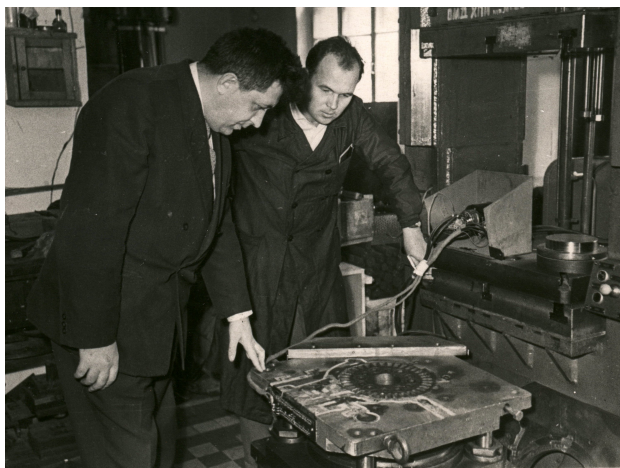
Рис. 14 – Старший викладач кафедри О.А. Коломойцев та інженер П.Полуктов досліджують навантаження на твердосплавний штамп для виготовлення ротор-статорів електричних двигунів
