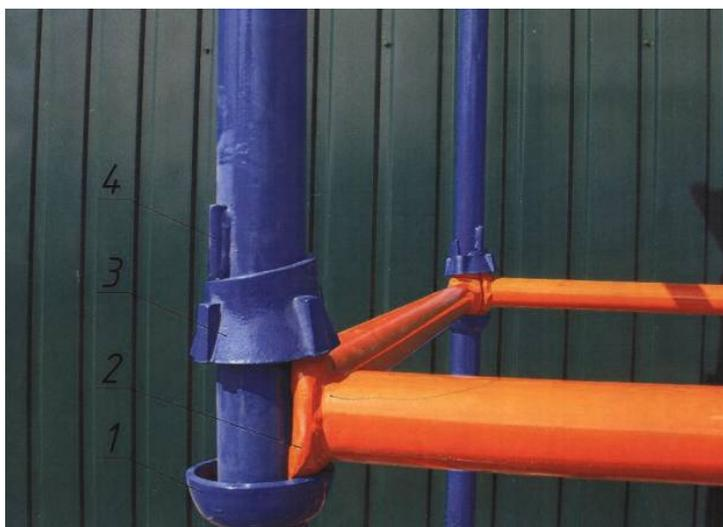
Рис.1. Узел стяжки вертикальной трубной опоры:
