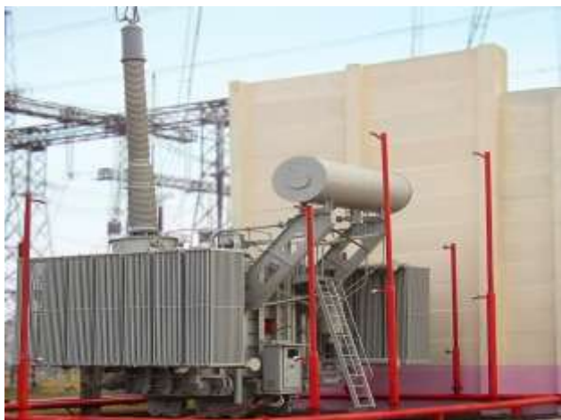
Рис. 1 – Однофазный шунтирующий реактор РОМ – 110000/750
