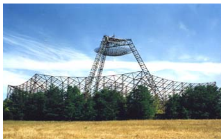
Радар НР с параболической антенной диаметром 100 м
