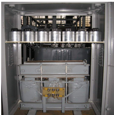
Рисунок 2 – Индуктивно-емкостной преобразователь
