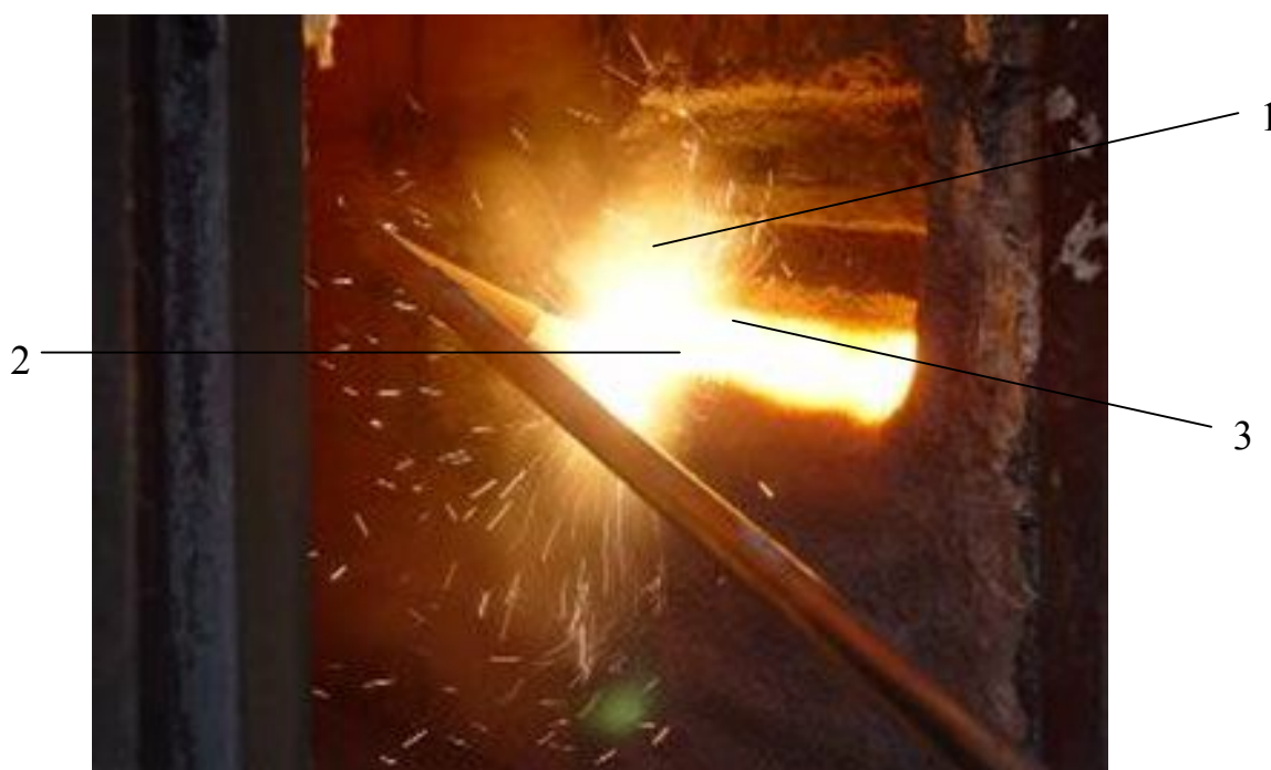
1 – факел горения смеси, 2 – торкрет фурма, 3 – огнеупорная кладка.
