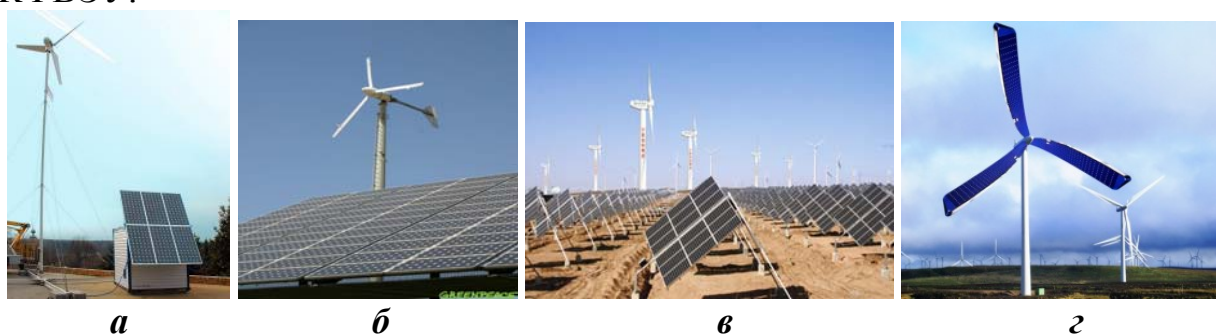
Рисунок 1.65 – а – российская КФВЭУ для нужд внутренних войск МВД и пограничной службы (центры боевого управления, огни освещения и навигационное обеспечение, посты технического наблюдения, радиоретрансляторы, дежурные помещения, испытательные полигоны); б - КФВЭУ в жилом секторе американского штата Вермонт; в – китайская КФВЭУ пиковой мощностью 20 МВт; г – инновационное решение ученых из ливерпульского университета (Великобритания) - модернизировать традиционный ветроэлектрический генератор путем оснащения его лопастей фотоэлектрическими модулями
