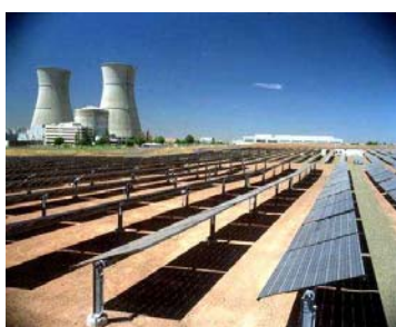
Рисунок 1.17 – Фотоэлектрические солнечные электростанции мощностью: а – 350 кВт в Саудовской Аравии (1981 г.); б – 2 МВт рядом с бездействующей АЭС в США; в - 10 МВт в Испании
