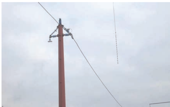
Рисунок 3 – Линия 10 кВ с подвешенным над ней высоковольтным электродом
