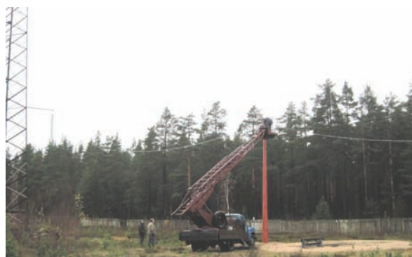
Рисунок 2 – Монтаж УЗАП на опоре и общий вид испытательной площадки
