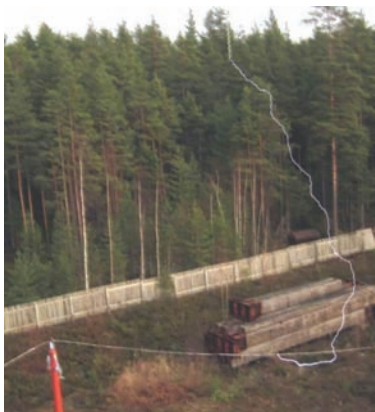
Рисунок 17 – Типовая форма разряда коммутационного импульса в изолированный провод линии 10 кВ без защиты
