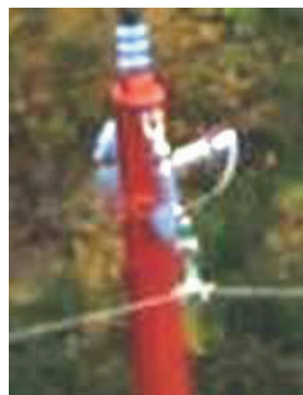
Рисунок 12 – Пробой искрового промежутка УЗАП-К
